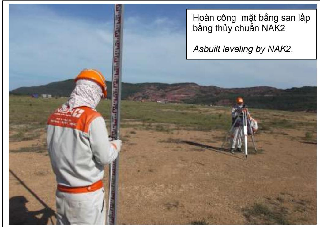
Hoàn công mặt bằng san lắp bằng thủy chuẩn NAK2
